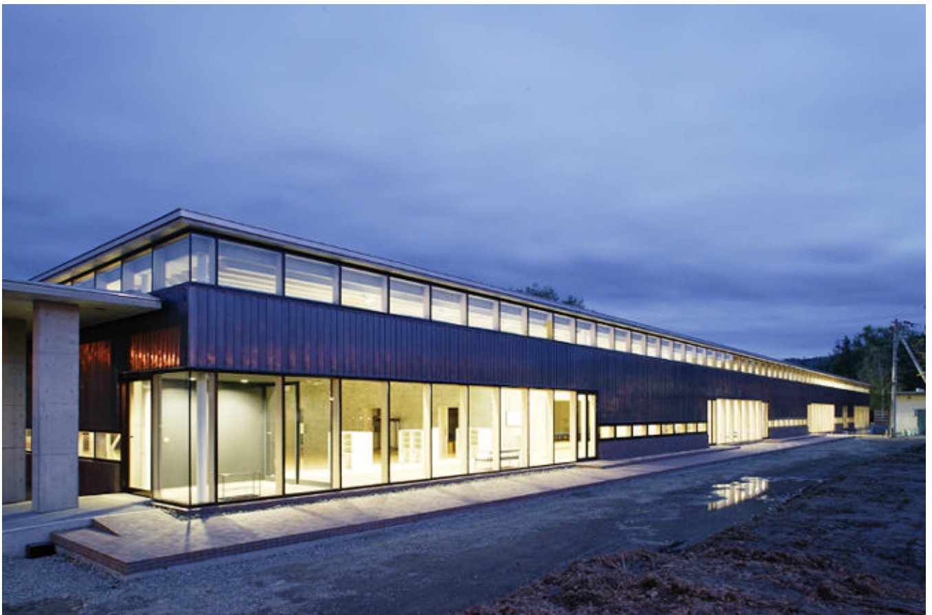
写真-2 弊社 i wood screen system 施工例(2) 平成16年施工 陸別保険センター
