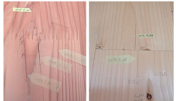
写真6 フィンガージョイント周辺に多数生じる細かい干割れの例
