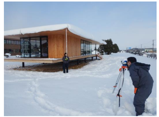
写真2 たわみ測定の様子
