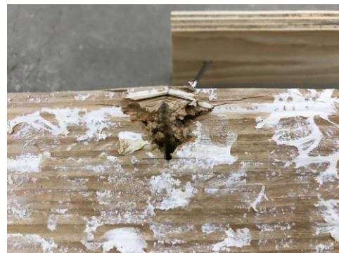
図4. ホワイトウッド腐朽試験体の変形性状
