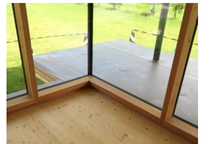
写真 5 開口部-床取り合い （フローリング施工前）
