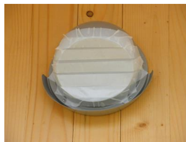
写真 6 換気装置目張り処理 (右：吸気口部分拡大)
