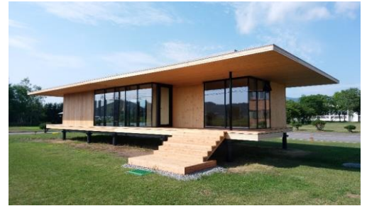
写真 1 CLT 実験棟外観
