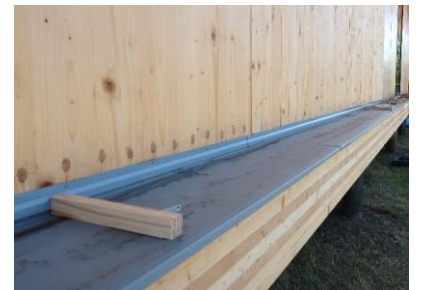
写真 3 床-壁取り合い（外周）
