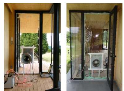
写真 8 測定実施状況 (左：屋内側，右：屋外側)
