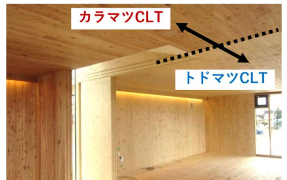
写真 2 内装現し仕様とした CLT 実験棟
