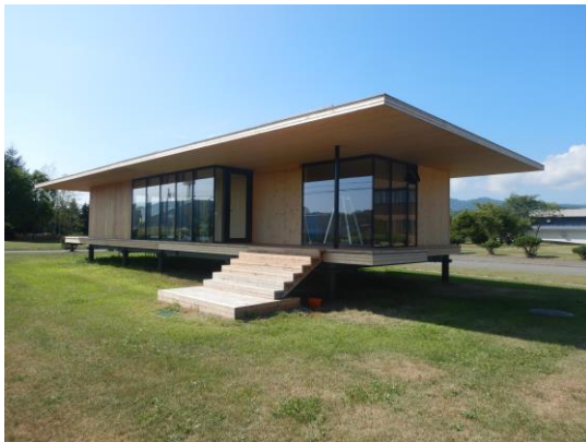
写真 1 林産試験場 CLT 実験棟外観
