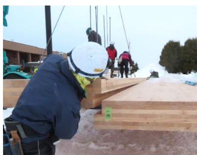
写真10 床・屋根パネル間取り合い
