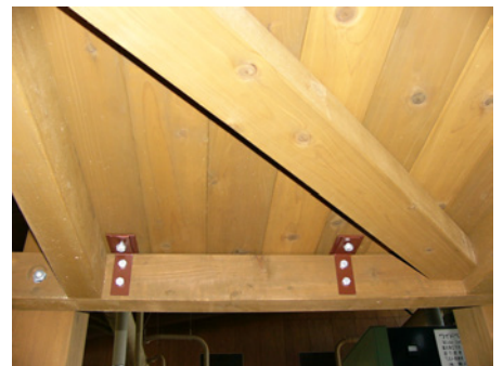
図11 梁への固定状況
