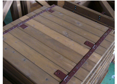
図10 ユニット化した床(裏面)
