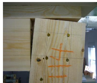
写真 3 CJ-NG 縦枠柱頭部
