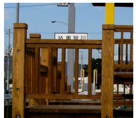
図8 水平部材の保護 (手摺の笠木)
