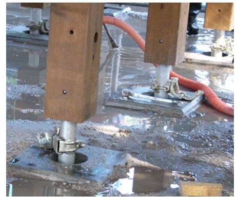
図9 形状を変更した柱脚金具
