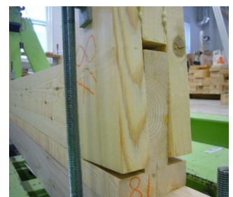
写真 4 CJ-NG 縦枠柱脚部
