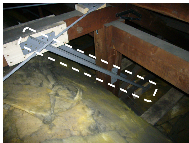
図-6 小屋裏から見た鋼製方杖部材 (図-5の破線で囲まれた部材)
