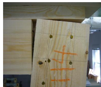
写真 3 CJ-NG 縦枠柱頭部
