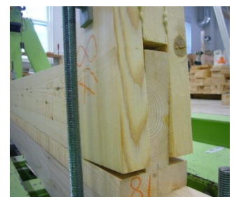
写真 4 CJ-NG 縦枠柱脚部
