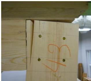
写真 1 CJ-G 縦枠柱頭部
