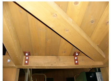
図11 梁への固定状況
