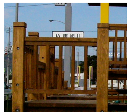
図8 水平部材の保護 (手摺の笠木)
