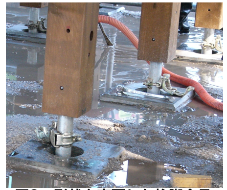
図9 形状を変更した柱脚金具
