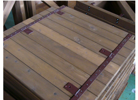
図10 ユニット化した床(裏面)
