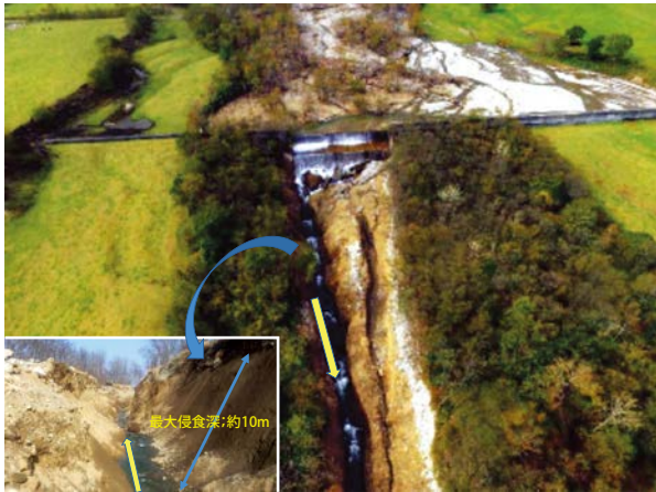
写真-3 芽室川3号砂防堰堤下流側の河床洗掘
