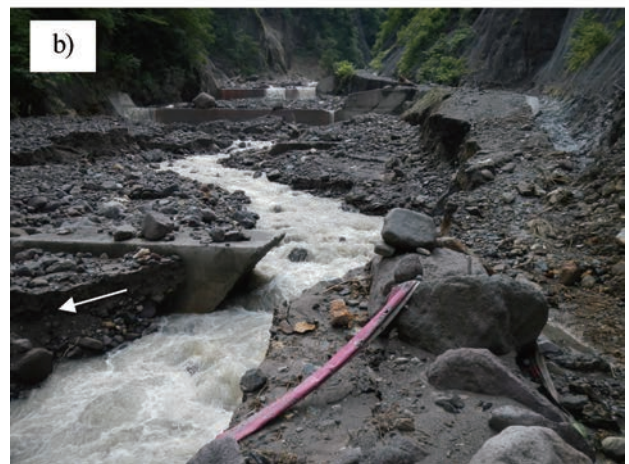
写真-2 黒岳沢川上流部の状況 (a) UAVからの写真（8/24撮影）、b)は治山施設の損傷（8/25撮影）
