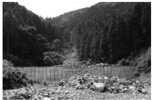
写真-3 最上流の治山ダム堆砂状況（2016年7月23日撮影）
