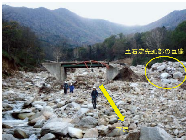
写真-1 ベケレベツ川河道内の侵食および石礫等堆積状況(旧日勝スキー場付近清流橋)
