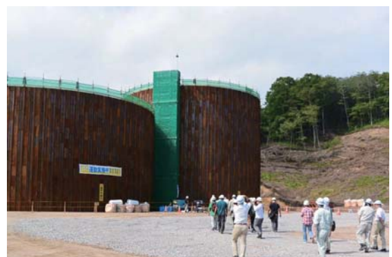
③覚生川1号砂防堰堤（火山泥流対策）
