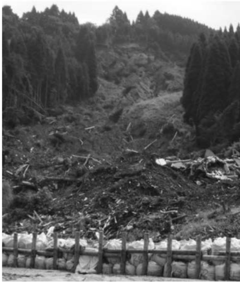
写真-11 火の鳥温泉の崩壊と土嚢バックによる対策 6月の雨による大きな変状は認められない（2016年7月24日撮影）
