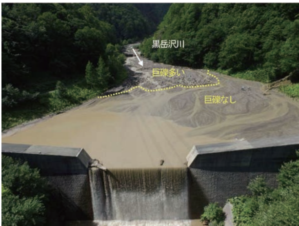
写真－4 黒岳沢川第 1 号えん堤の状況（8/24 撮影） Photo 4 The Kurodakesawagawa No. 1 sabo dam
