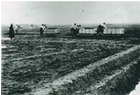
泥流堆積物への客土作業(被災翌年1927年より開始) (出典:上富良野町郷土館)
