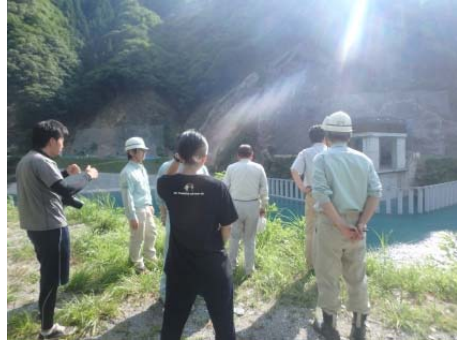
小渋ダム 排砂バイパストンネル入口
