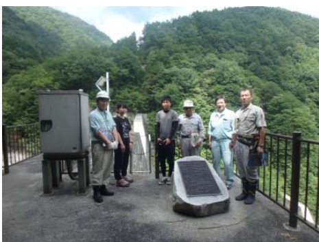
飯島第6砂防堰堤
