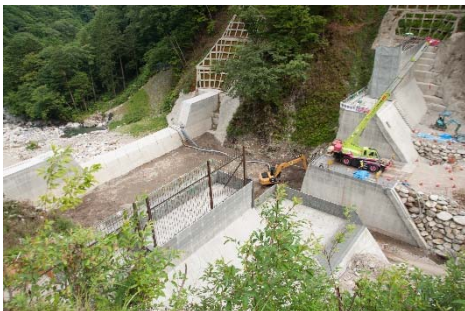
黒川第4砂防堰堤
