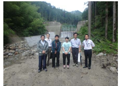
梨子沢第2砂防堰堤
