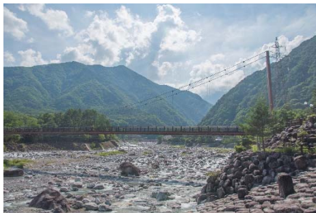
大田切床固工群
