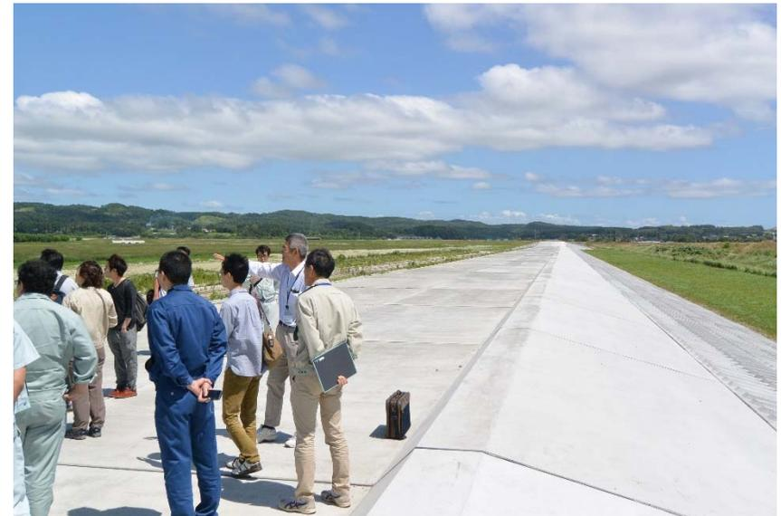
②舞鶴遊水地 (洪水時の水位上昇抑制) の越流堤
