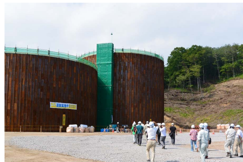
おほっふ ③覚生川1号砂防堰堤（火山泥流対策）
