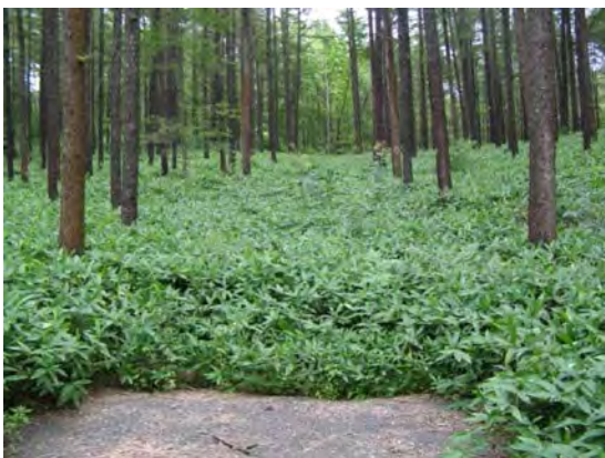
写真-2 砂利を敷かない作業路
