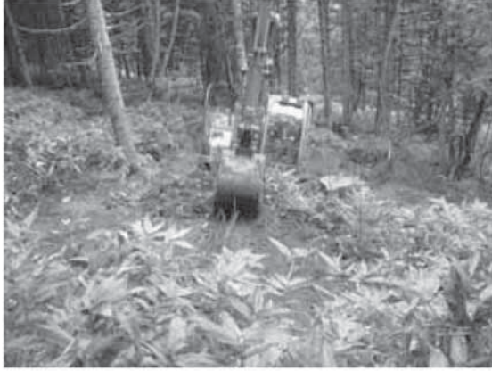
写真-1. 小面積樹冠下地がきの作業風景
