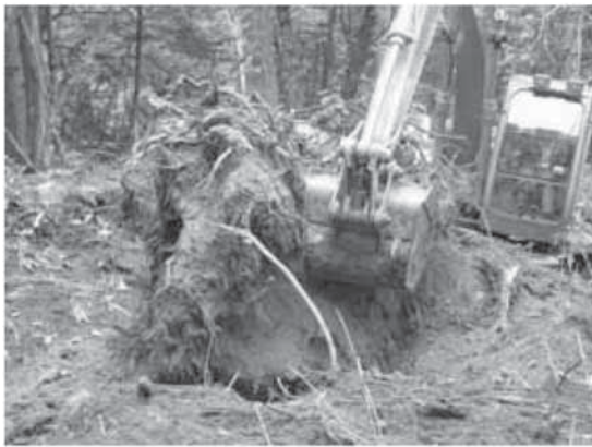
写真-2. 人工根返し処理の作業風景
