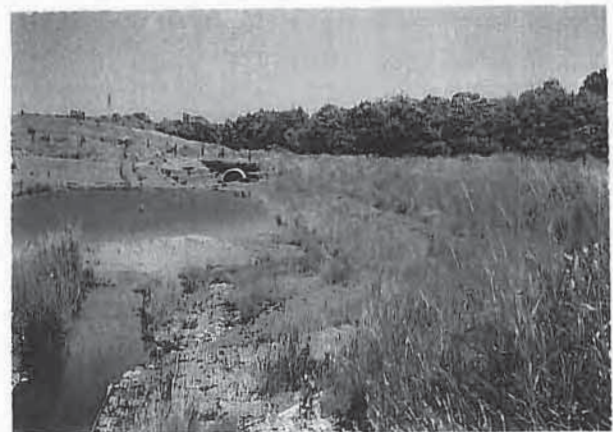
写真-2 幹線排水路に合流する直上部の沈殿池 ヤナギ類編柵+水草が水質浄化に貢献する
