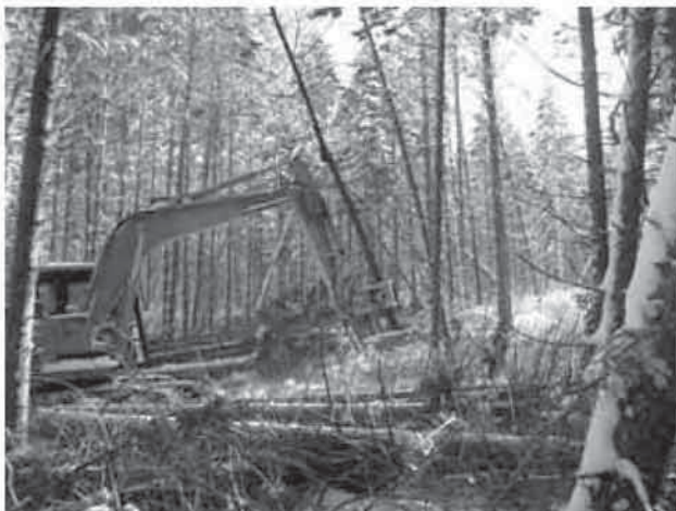
写真-3 供試機による風倒木の伐倒作業状況 手前に作業の支障となる倒伏木がみられる
