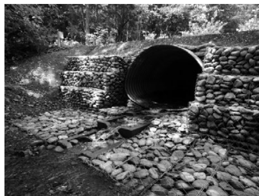
図-6 落差洗堀を改良したコルゲート下部
