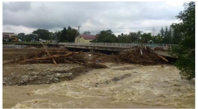
清水町市街地ペケレベツ橋(道道)での流木・土砂による閉塞状況
