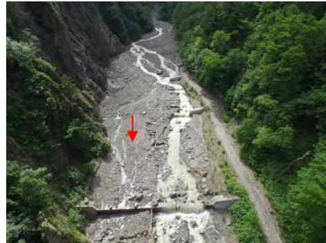
写真7 治山堰堤による土砂の捕捉 (UAVからの撮影)
