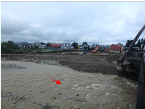
写真12 石山橋上流での左岸側の側岸侵食
