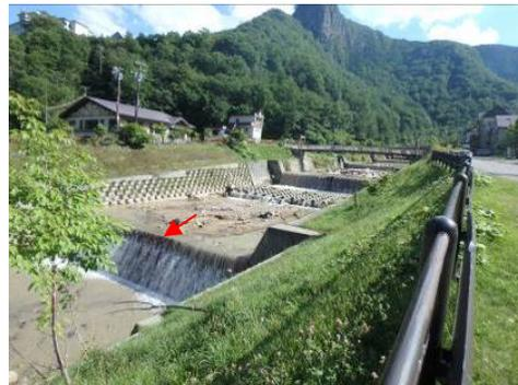
写真9 砂防堰堤下流の溪流保全工
