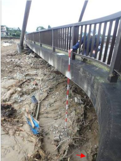
写真10 石山橋での土砂・流木の堆積状況
