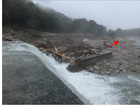
写真4 1号砂防ダム下流の礫・流木の堆積
