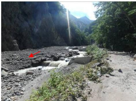
写真6 治山堰堤による土砂の捕捉
