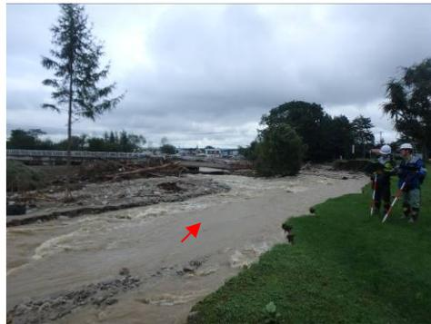
写真13 石山橋下流での右岸側の側岸侵食、石山橋の下流のペケレベツ橋（下流）の落橋
