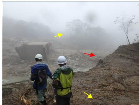
写真2 旧日勝スキー場に向かう道路への土砂流出
