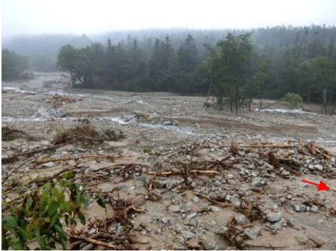
写真3 1号砂防ダムの土砂・流木の堆積状況
