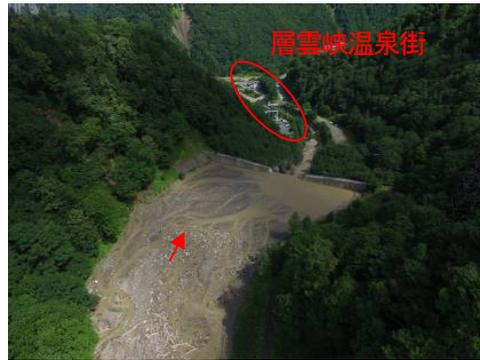
写真5 砂防堰堤による土砂の捕捉 (UAVからの撮影)
