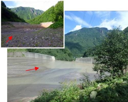
写真4 砂防堰堤による土砂の捕捉
