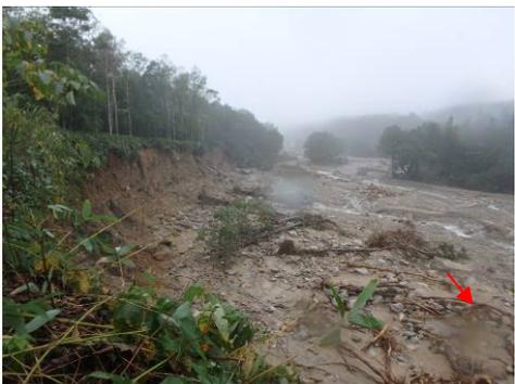
写真5 1号砂防ダム右岸上流の側岸侵食
