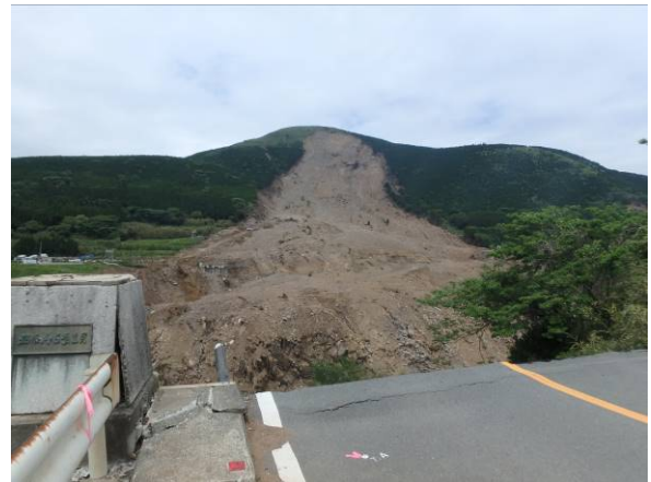
阿蘇大橋地区における大規模崩壊
