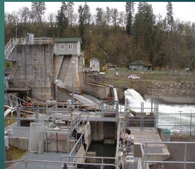
パワーデルダムの遡上魚捕獲施設
