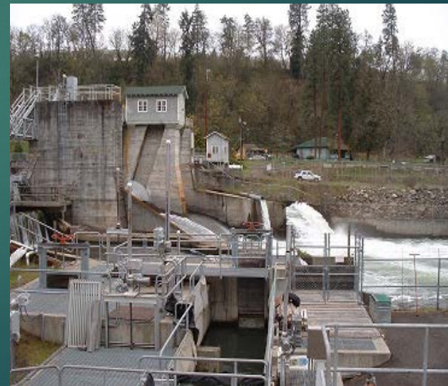
パワーデルダムの遡上魚捕獲施設
